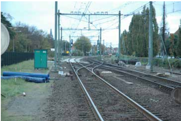
^ Te verwijderen kruiswissel aan de W. Zelleweg/Patijnweg
