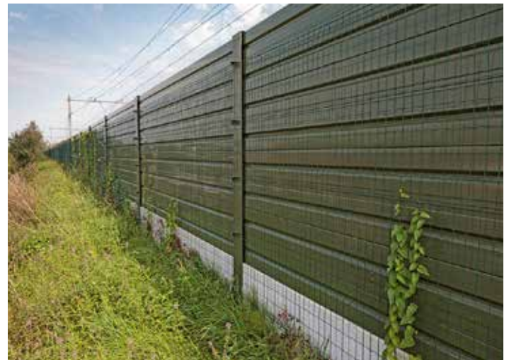
^ Geluidsscherm net geplaatst zonder begroeiing.
