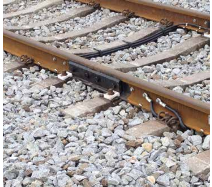
^ Vervangen Elektrische Scheidinglas
