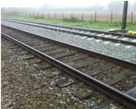
▲ Houten dwarsliggers (voorgrond) en ▲ betonnen dwarsliggers (achtergrond)
